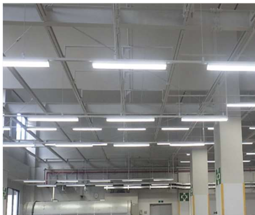
屋内電気工事
