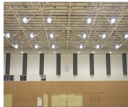
LED照明工事
